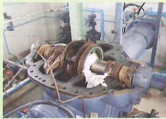
「ポンプ内部に絡みついたハウス用ビニール類」
