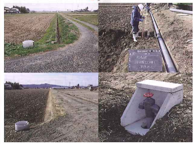
ニツ屋地区長寿命化 パイプライン化工事実施状況
